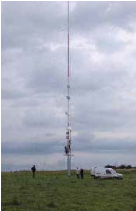
事故のリスクゾーンの高さでコウモリの活動の音声を録音するために、自動バットディテクターを風況ポールに取りつけた。フランスにて。© J. Sudraud
