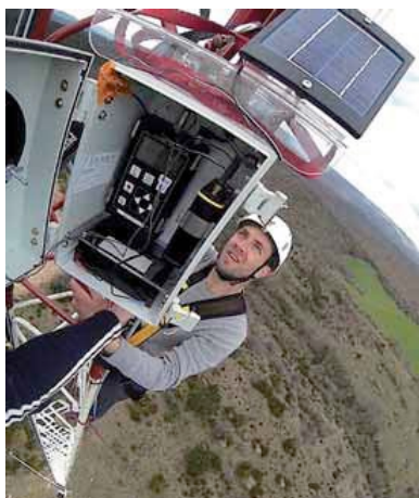
自動バットディテクターシステムが、風況ポールに設置された。フランスにて。© EXEN
