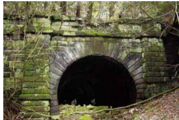
図1 旧長野隧道坑門跡（三重県津市）。
