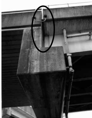
写真6 橋桁と橋桁の継ぎ目(丸印)
