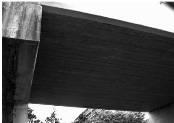
写真3 陸橋下のスリット
