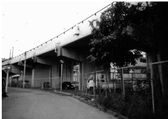
写真1 埼玉県久喜市の県道陸橋(下は駐車場)
