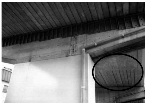
写真4 橋桁と橋脚の継ぎ目(手前)と充填材使用箇所(丸印)
