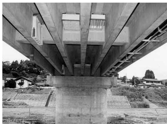
写真1 赤穂土橋に取り付けられた3つのコウモリ保護施設
